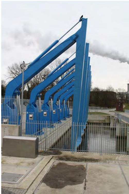
**Einlaufwerk mit Rechen für Treibgut (Foto Steinbrecher 2014)**
