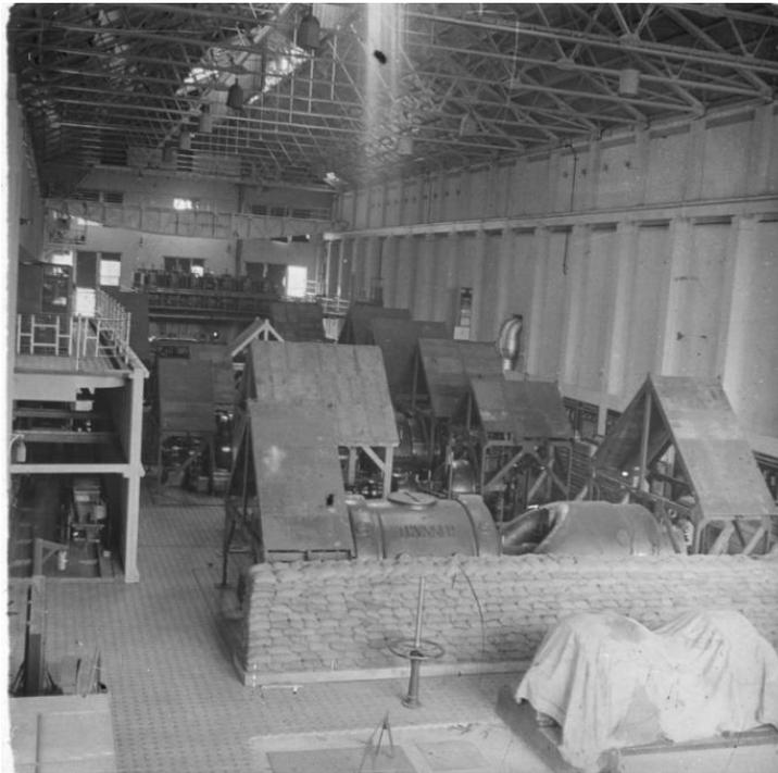
**Schutzaufbauten für die Generatoren**
