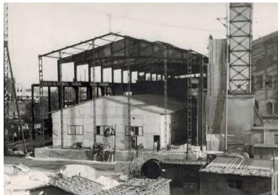
**Wiederaufbau des Maschinenhauses mit provisorischem Barackenüberbau (1947)**
