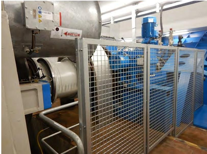
**Rohrturbine (Foto: Steinbrecher)**
